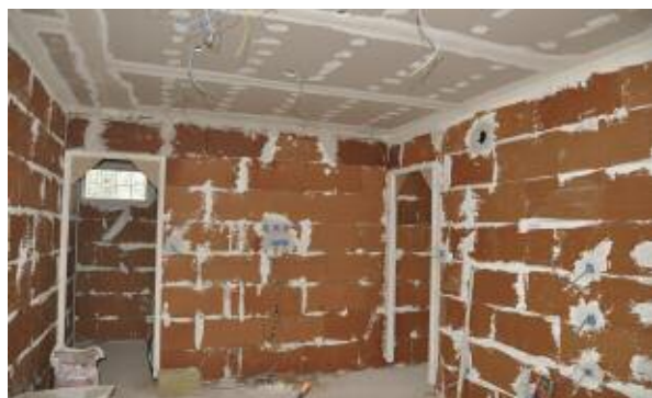
Scellement des pots destinés à recevoir prises électriques, prises RJ45 pour le réseau et la VDI, interrupteurs, détecteurs de présence et écrans tactiles.
