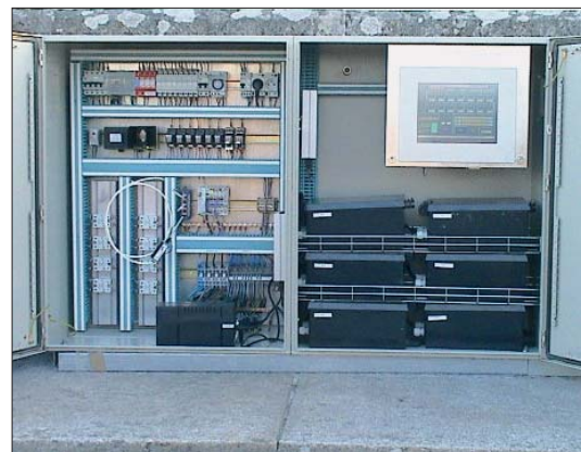
Disposée à même la chaussée du Viaduc, l'armoire "maître" intègre le PC industriel.
