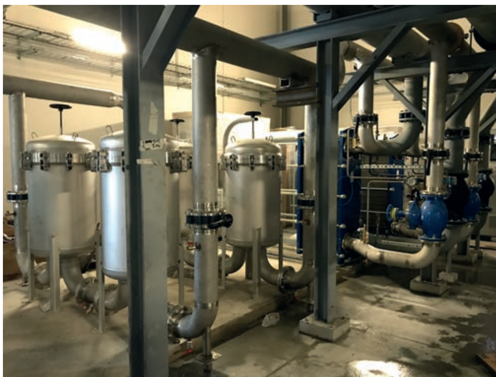
► Filtres d'exhaure de la géothermie de la ZAC du Moulon.
