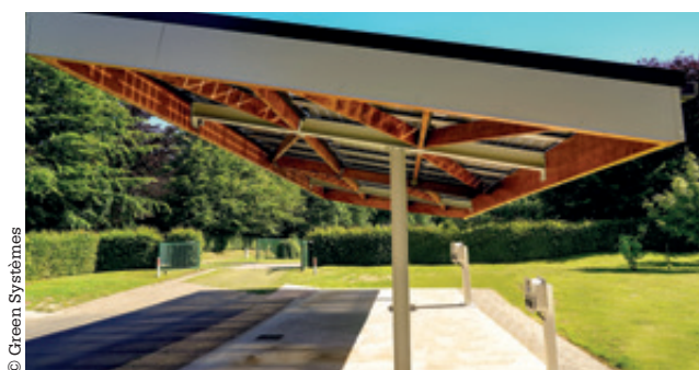
► Ombrière photovoltaïque connectée à un système d'arbitrage consommation-production.
