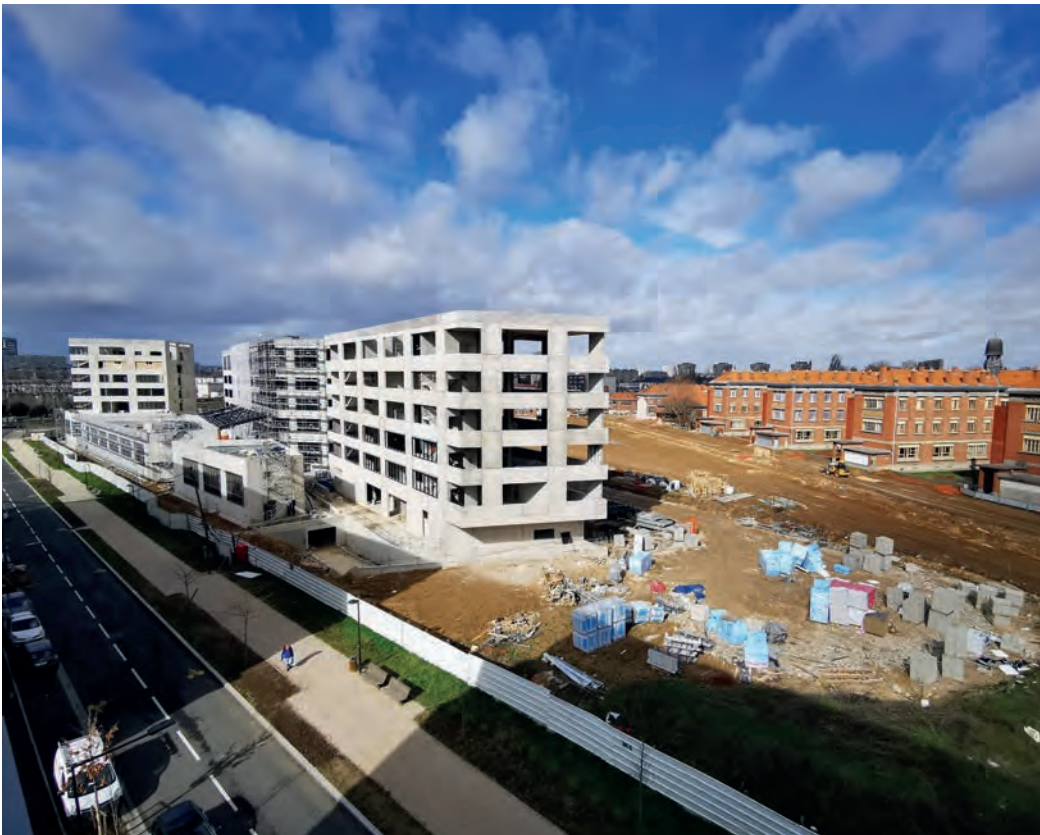
Le chantier du futur éco campus dédié à l'apprentissage.
