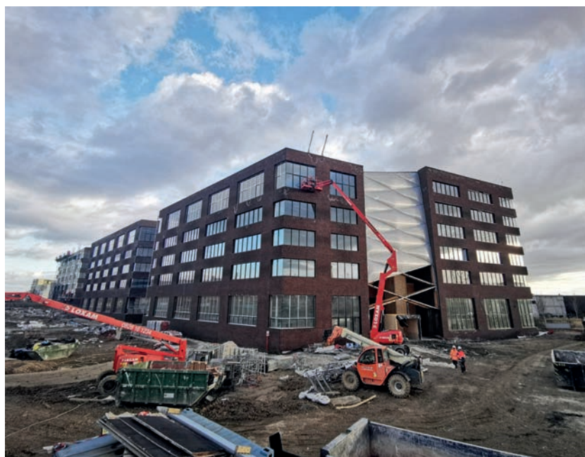
Le site prochainement réceptionné accueillera les apprentis dès septembre 2022.
